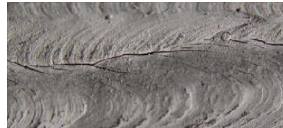
Fisura en caliente
